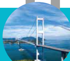
来島海峡大橋 【塔頂高】海面から184m
